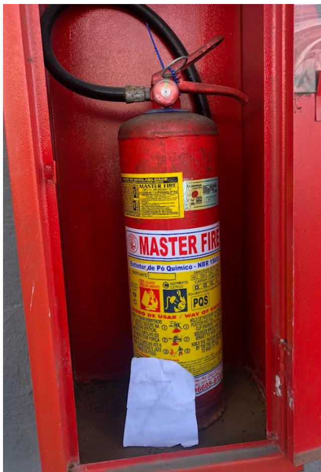
Estacionamento Externo - Abrigo - PQS
