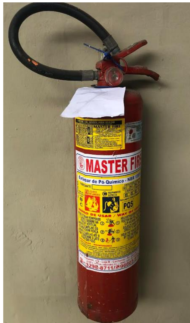
Estacionamento Coberto - PQS
