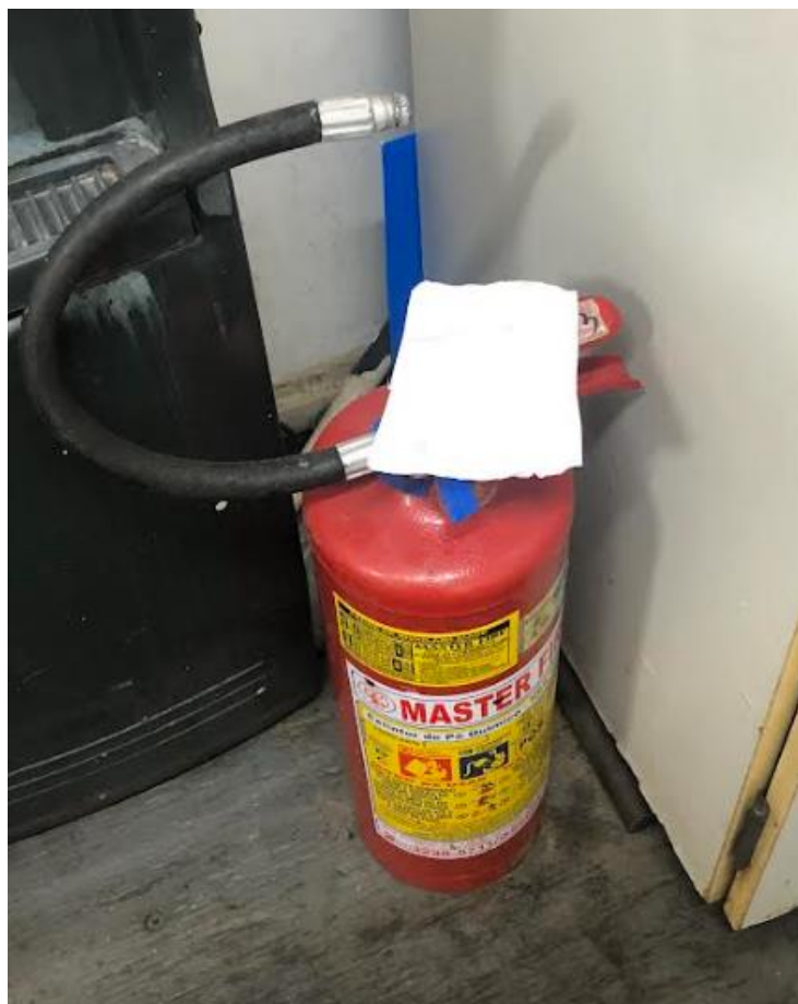
Rompedor – Container - PQS
