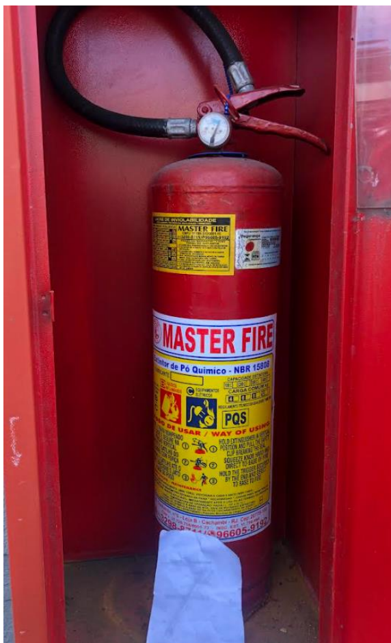
Estacionamento Externo - Abrigo - PQS
