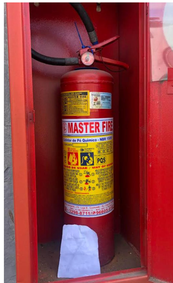
Estacionamento Externo - Abrigo - PQS
