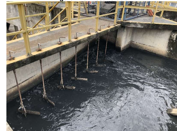
Figura 126: Desarenador.
