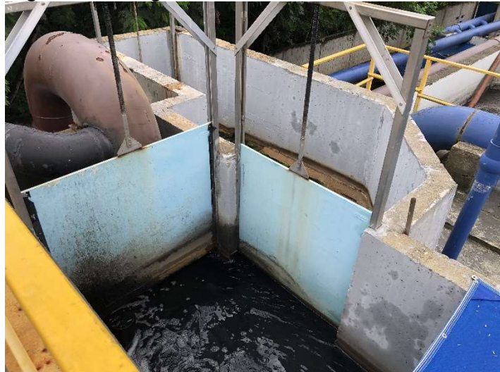
Figura 136: Chegando do Efluente no Reator Anaeróbio.
