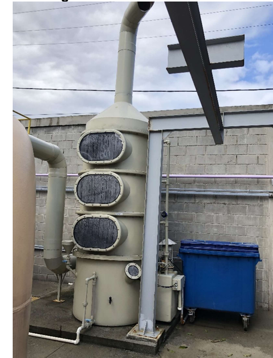
Figura 118: Lavador de Gases.
