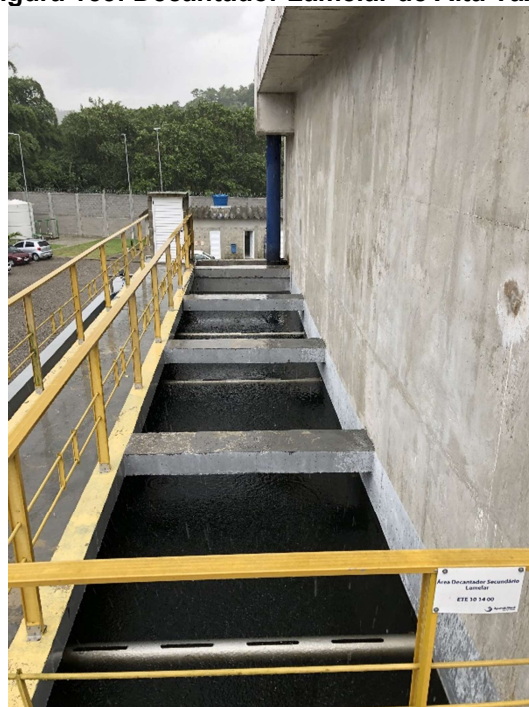
Figura 155: Decantador Lamelar de Alta Taxa.
