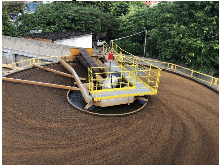
Figura 116: Decantador.
