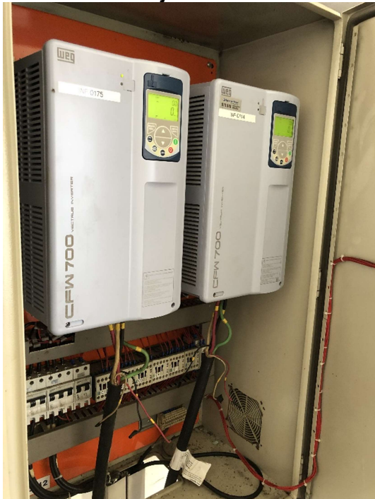
Figura 95: Acionamento dos Conjuntos Motobombas - EEE Paulo César.
