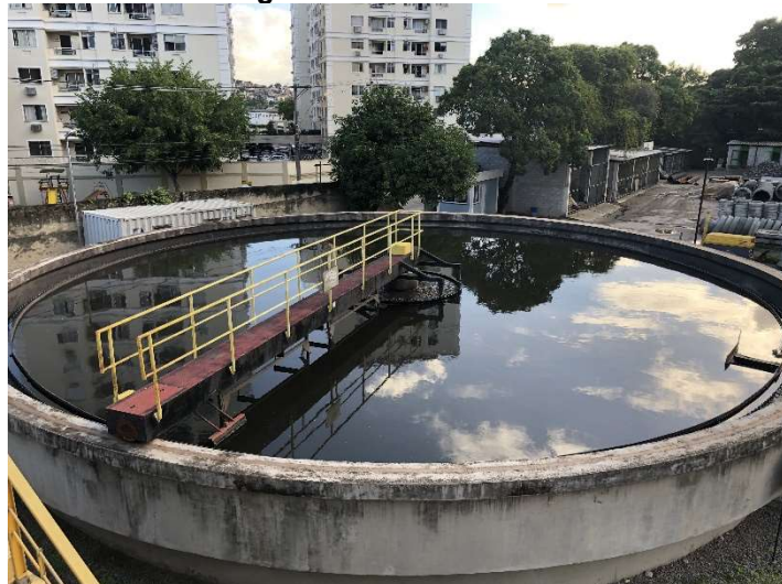
Figura 108: Decantador.
