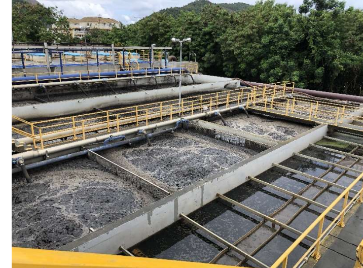
Figura 137: Tanques de Aeração.
