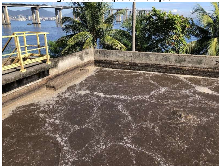
Figura 160: Tanque de Aeração.
