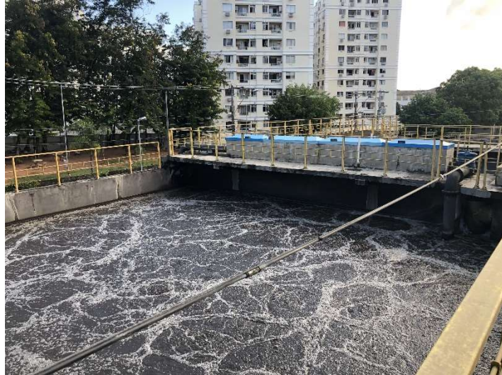
Figura 107: Tanques Aerados – Tratamento Secundário.
