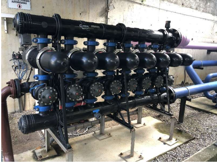
Figura 148: Sistema de Filtros de Membrana.
