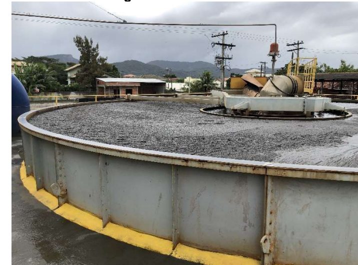
Figura 138: Decantador.
