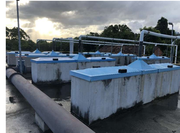
Figura 106: Reator Anaeróbio – Tratamento Primário.
