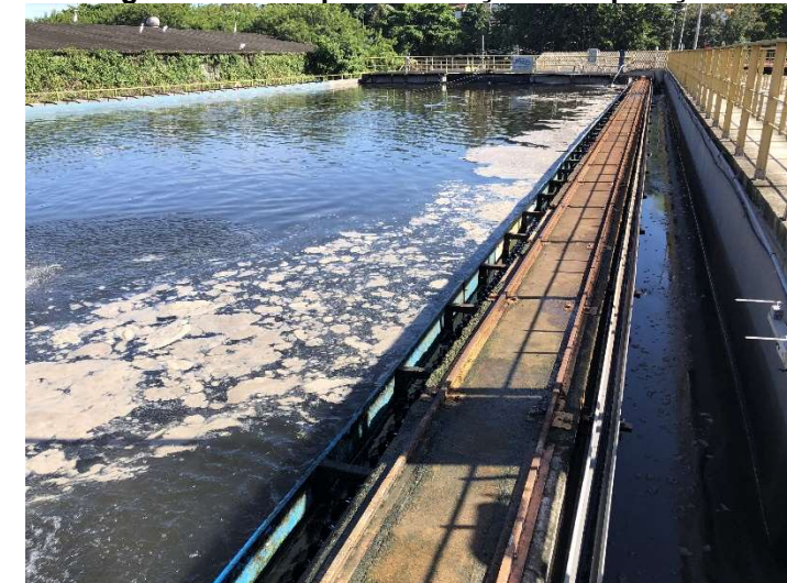
Figura 172: Tanque de Aeração em Operação.
