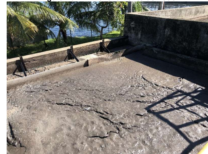
Figura 162: Armazenamento de Lodo.
