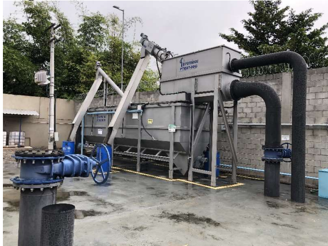
Figura 152: Tratamento Preliminar Automatizado.
