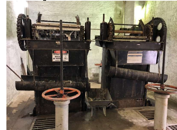
Figura 125: Gradeamento Mecânico.
