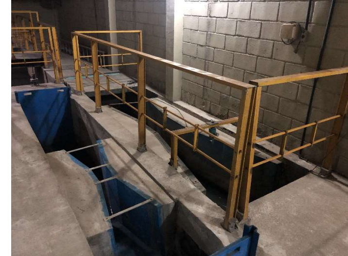
Figura 105: Tratamento Preliminar e Calha Parshall.
