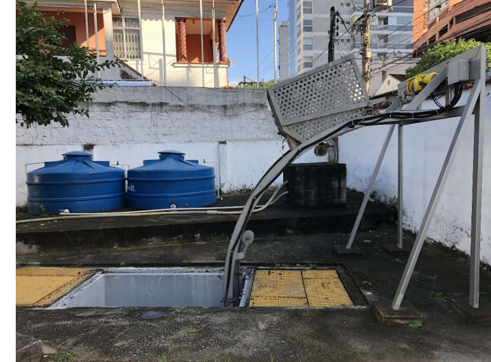
Figura 94: Gradeamento Automatizado
