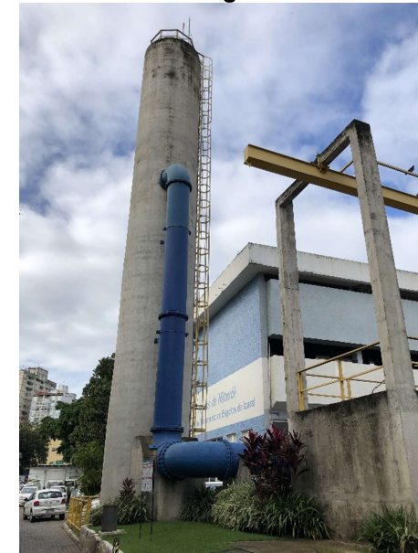
Figura 130: Chaminé de Carga do Emissário Submarino.
