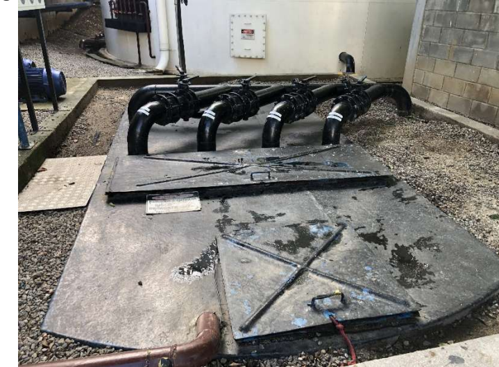
Figura 146: Recalque do Esgoto Após o Tratamento Preliminar.
