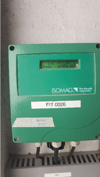
Figura 74: Macromedidor do Reservatório Caramujo.
