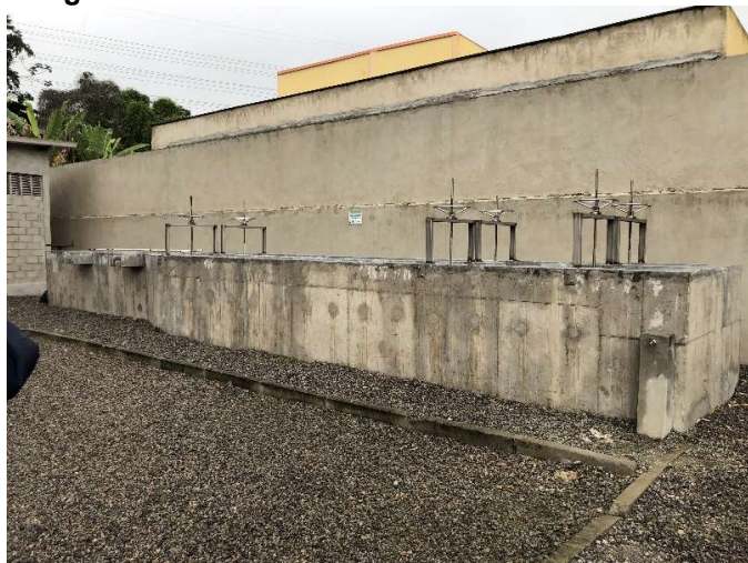
Figura 153: Tratamento Preliminar Convencional.
