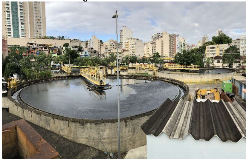
Figura 128: Decantadores.
