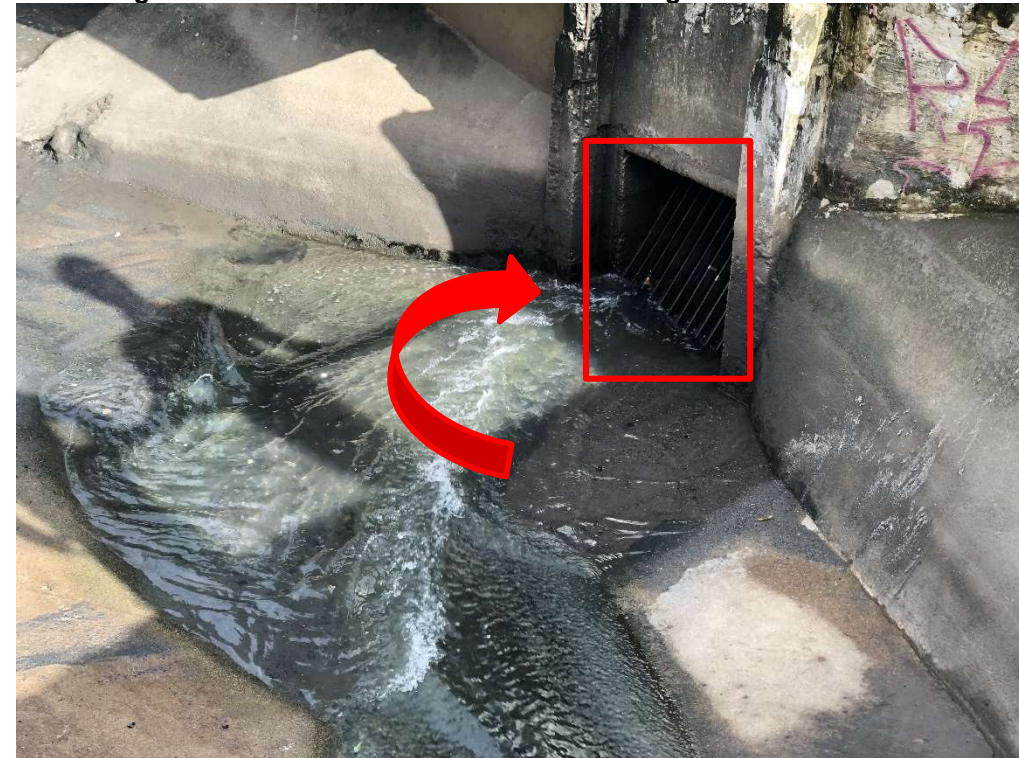
Figura 86: TTS Instalada em Canal de Drenagem no Bairro Icaraí.
